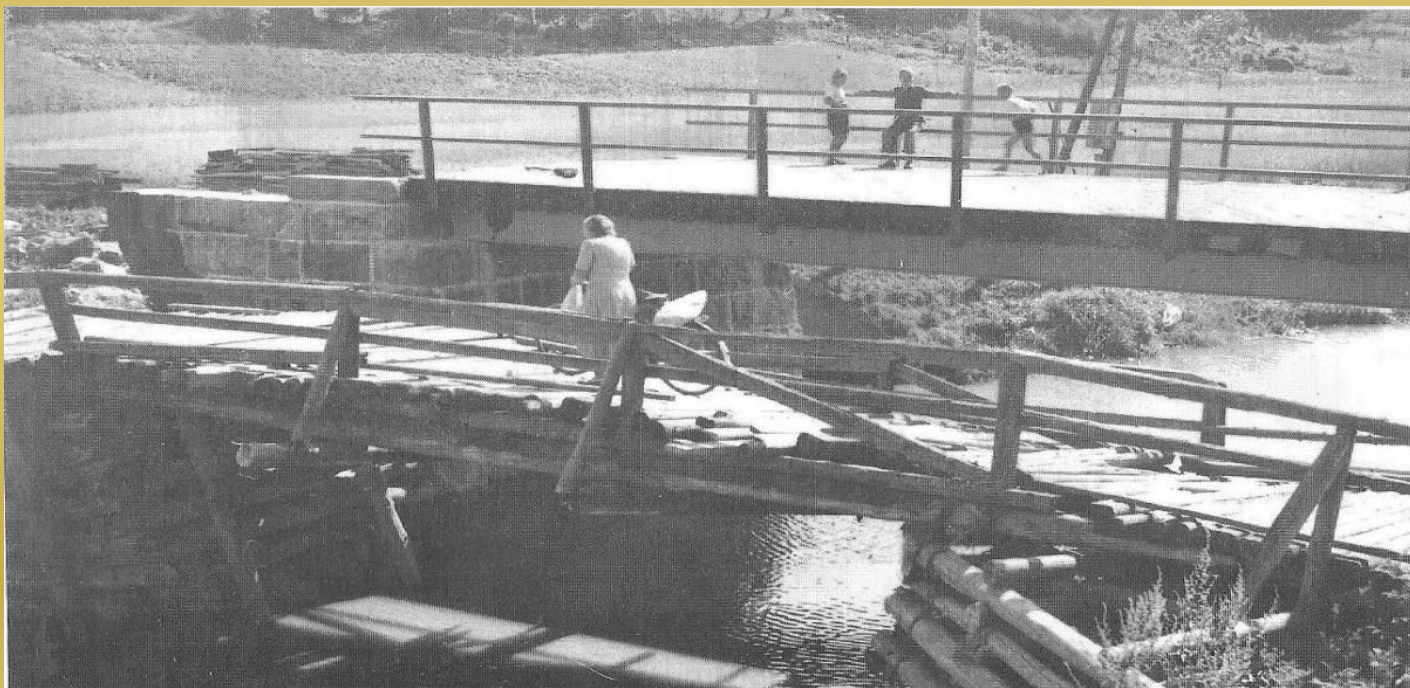
Jokivarren puusilta sai väistyä nykyaikaisen terässillan tieltä. Kuva vuodelta 1950
